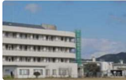
Krankenhaus Japan 1 x 50 kW
